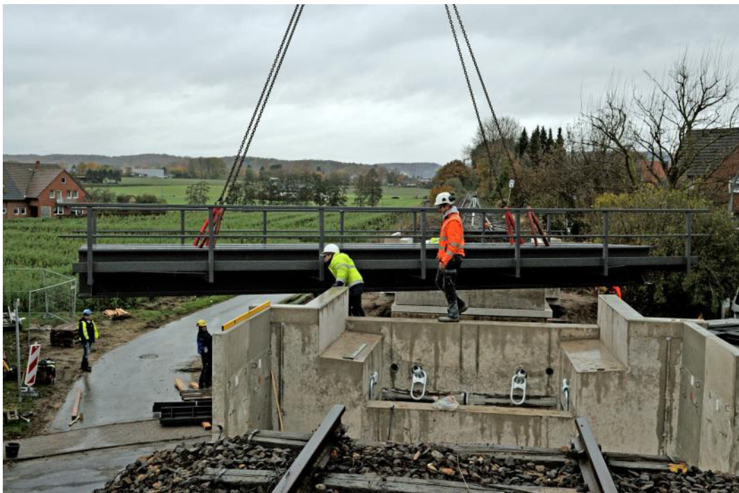
Ebenfalls am 12. November 2019 wird auch das Stahltragwerk des Brückenbauwerks „Am Kreuzbrink“ eingehoben.
