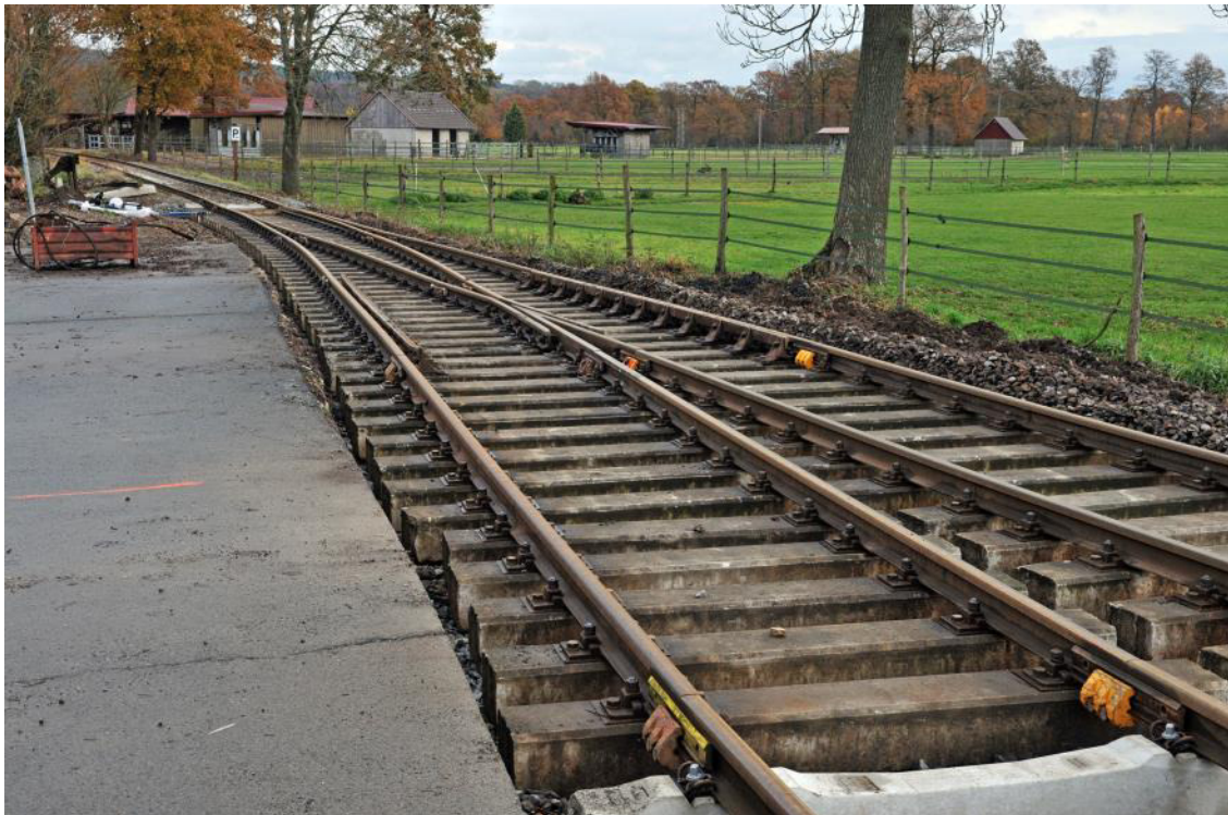
Einbau einer gebrauchten aufgearbeiteten Weiche mit Betonschwellen in Dörenthe (27.11.19). Holzschwellen soll es bei der Lappwaldbahn auch im Weichenbereich in Zukunft nicht mehr geben.
