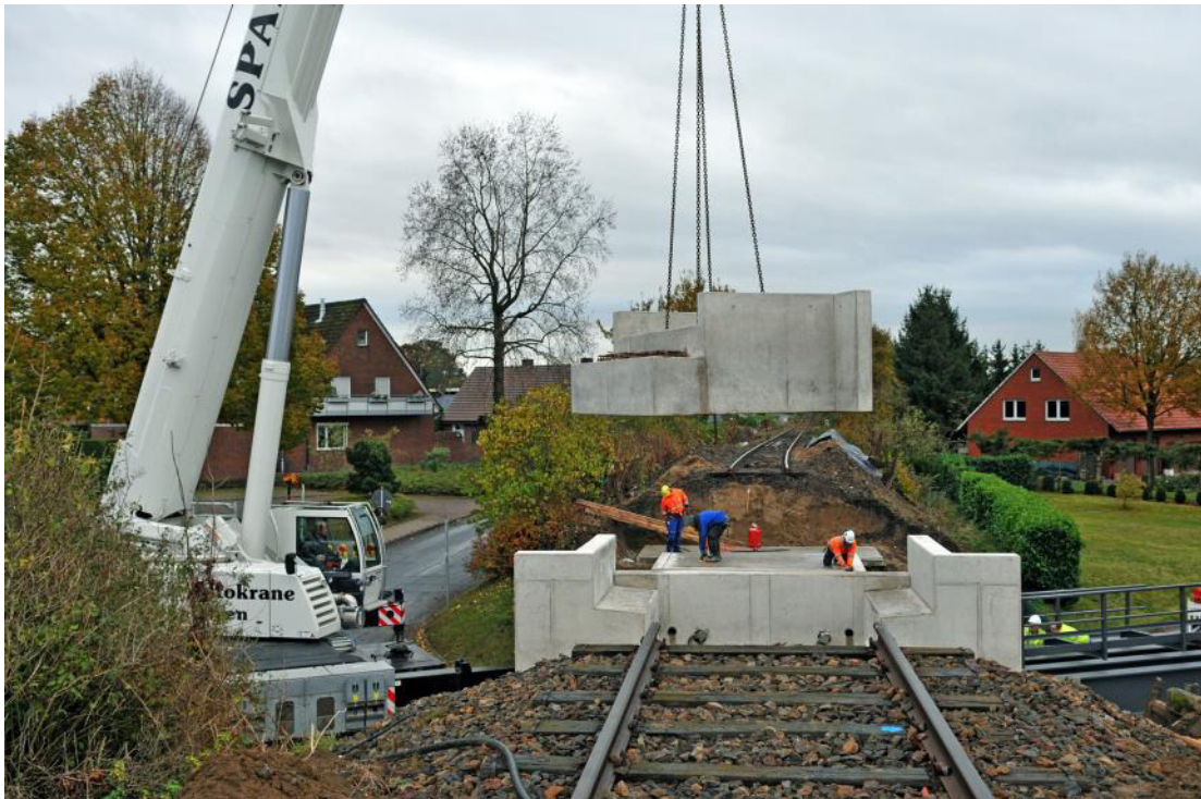
Brückenbaustelle in Glane an der Schulstraße. Ein 30 t schweres Widerlager wird am 12. November 2019 von einem Autokran auf ein saniertes Fundament gesetzt.
