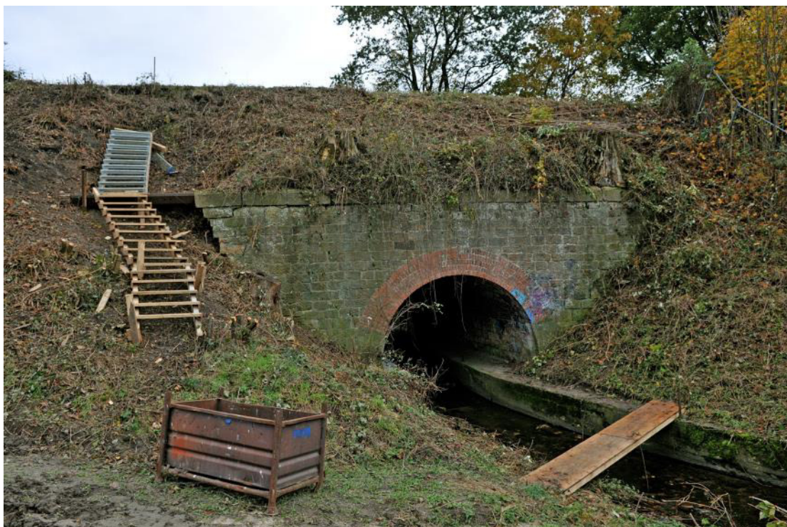
Die Gewölbebrücke „Glaner Bach“ erhält derzeit eine stählerne Innenschale. Saniert wird in diesem Bereich auch der Bahndamm.
